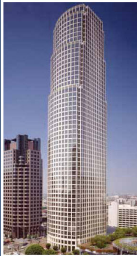
777 Tower, Los Angeles, CA.
